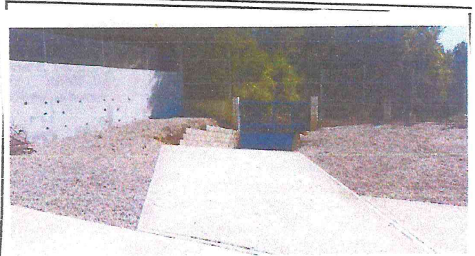
Foto 2: Portón de ingreso
