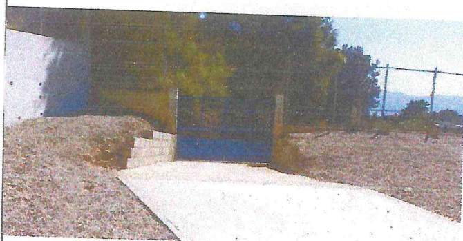
Foto 3: Portón de ingreso
